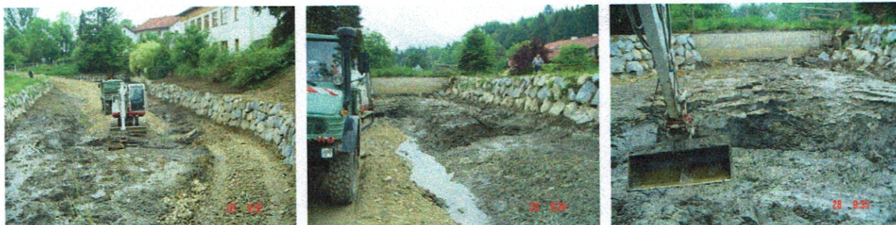
Abb. 2: Räumung des Dorfweihers in Reichertsheim mittels Abfuhr über eine Baustraße
